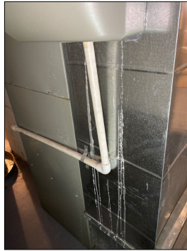
Humidifier leakage
